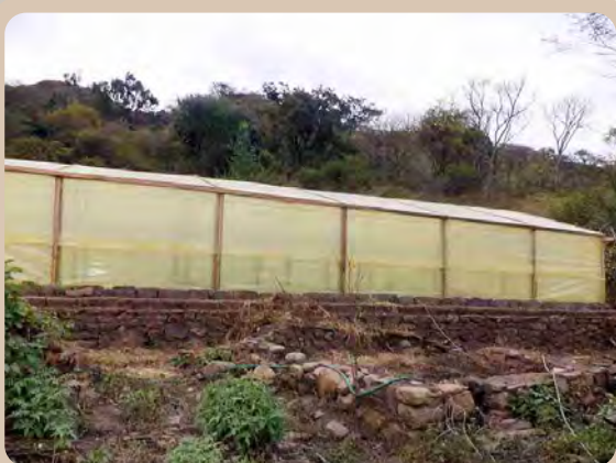
Vista exterior de la carpa solar
