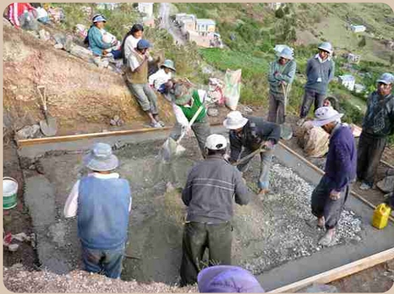
Durante la construcción de la obra
