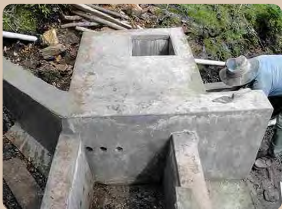
Construcción de la cámara de captación
