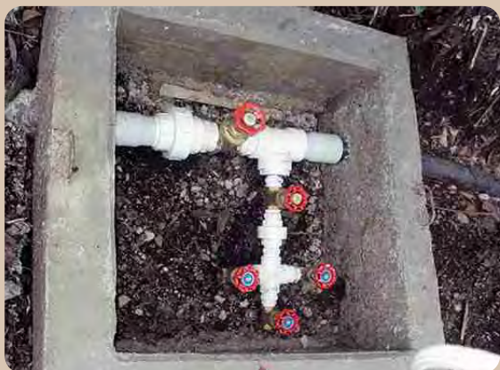
Construcción de cámaras de válvulas
