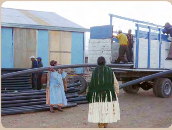
Descarga de materiales por los beneficiarios
