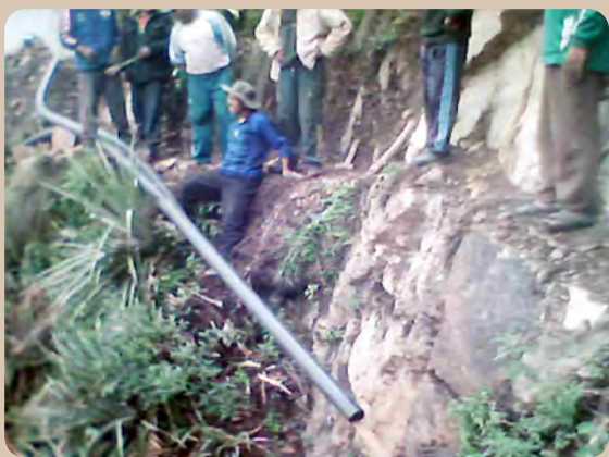
Implementación de la tubería
