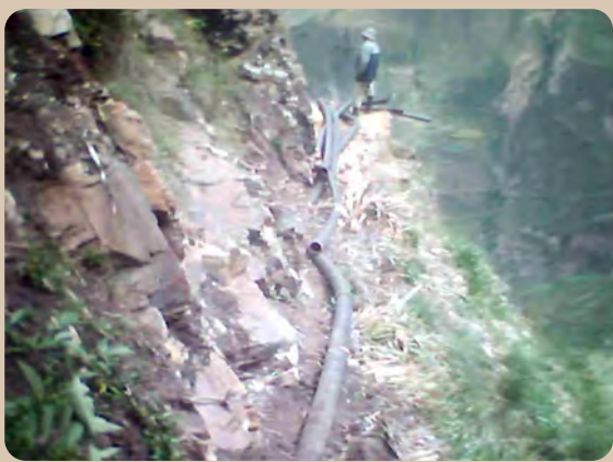
Implementación de la tubería
