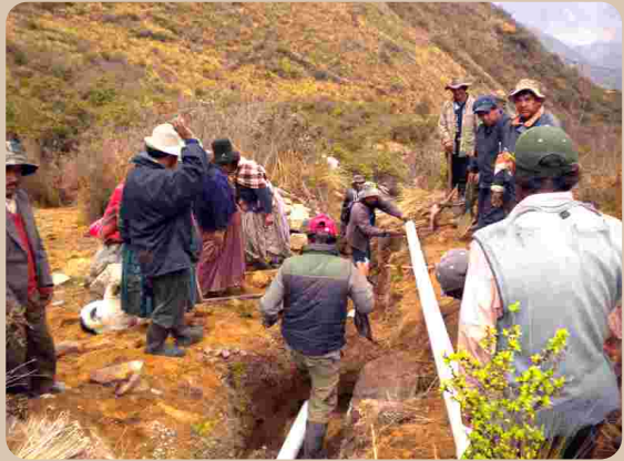
Comunarios trabajando en el nuevo sistema de riego
