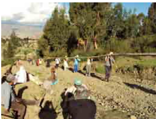
Traslado e instalación de tuberías de agua
